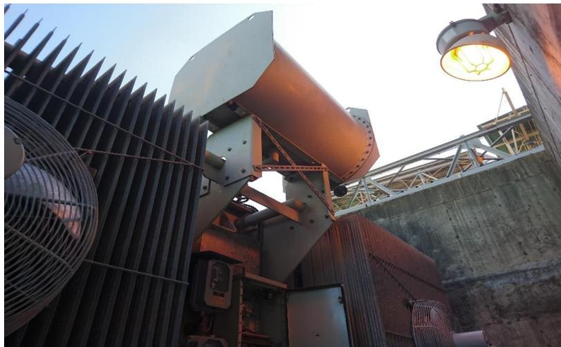
**Gambar 2.11** Tangki konservator pada transformator
